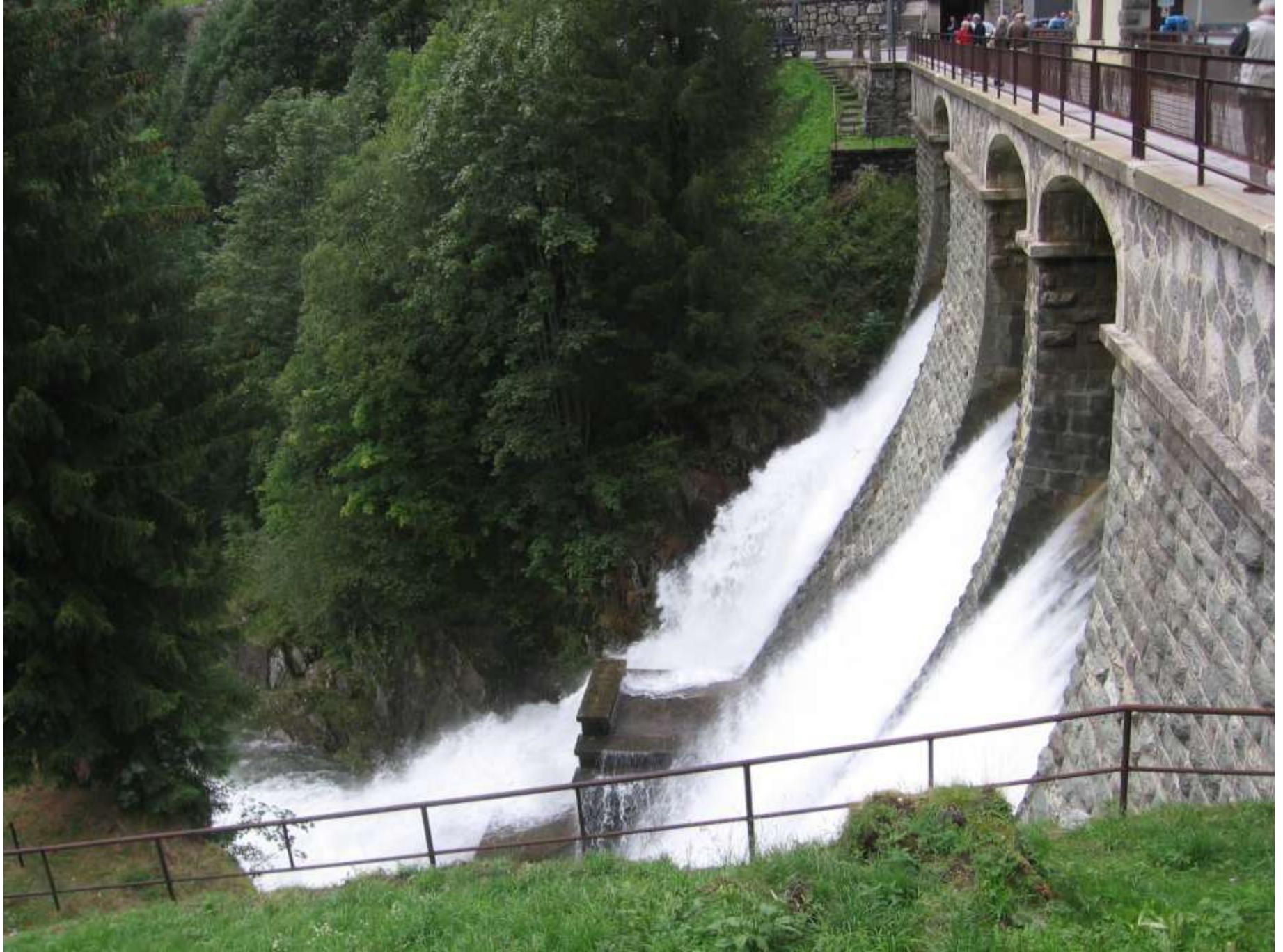
Carona: centrale idroelettrica
