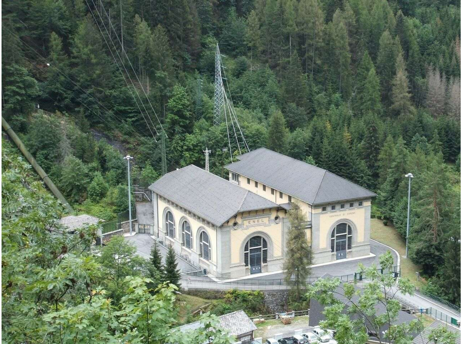
Carona: centrale idroelettrica
