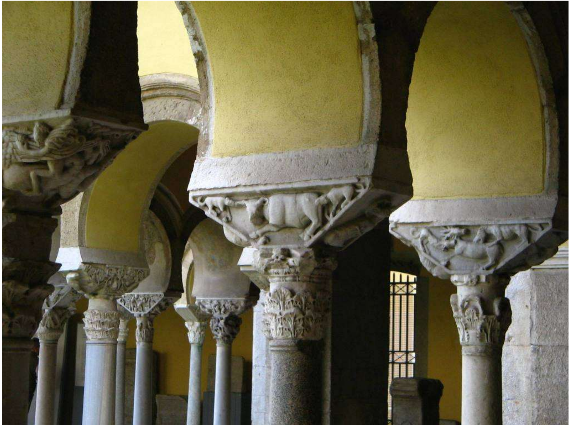
Chiesa di Santa Sofia: chiostro (Benevento, Campania)
