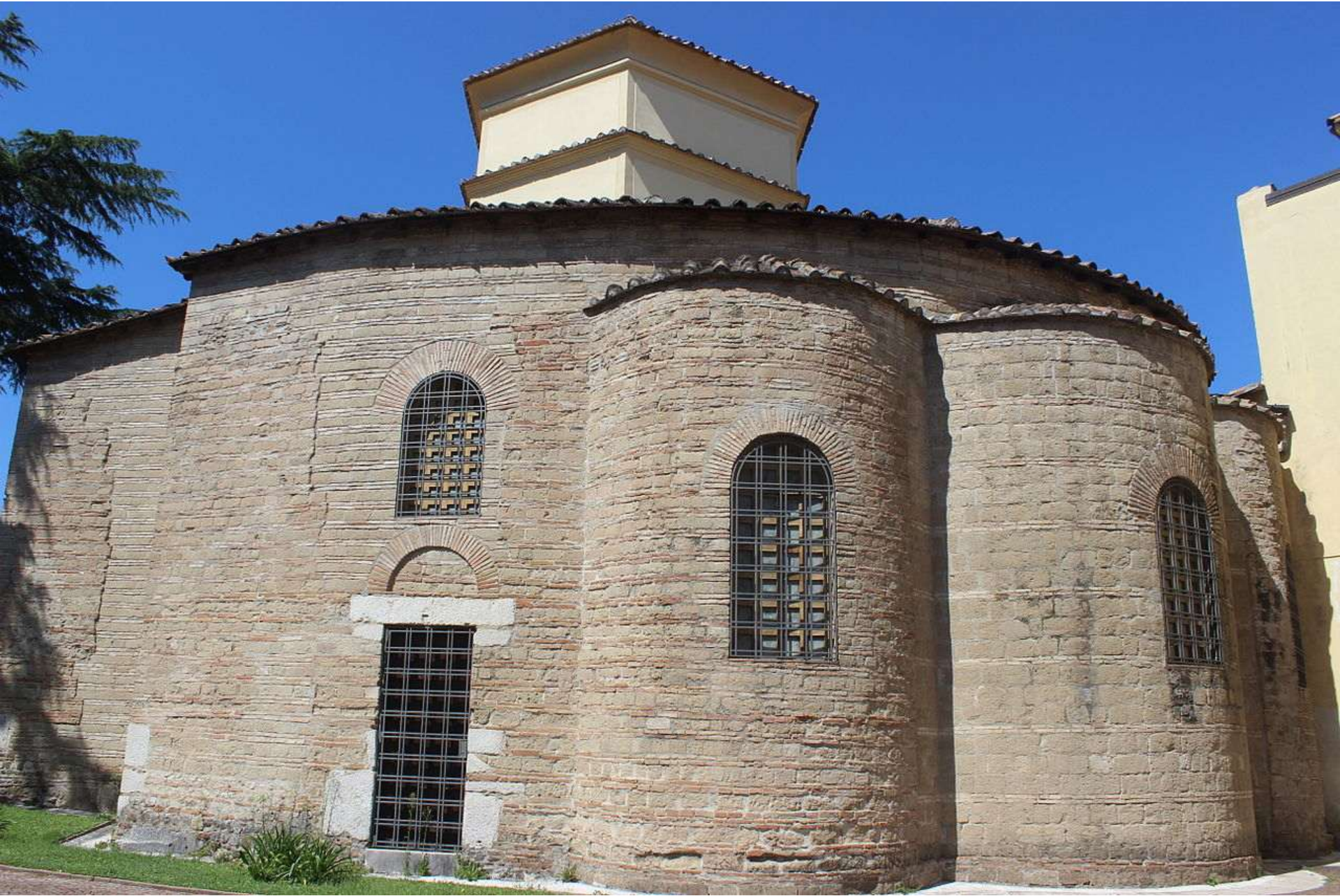
Chiesa di Santa Sofia: parte absidale (Benevento, Campania)
