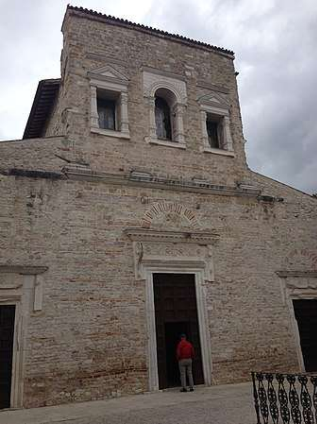
Chiesa di San Salvatore a Spoleto (Perugia)
