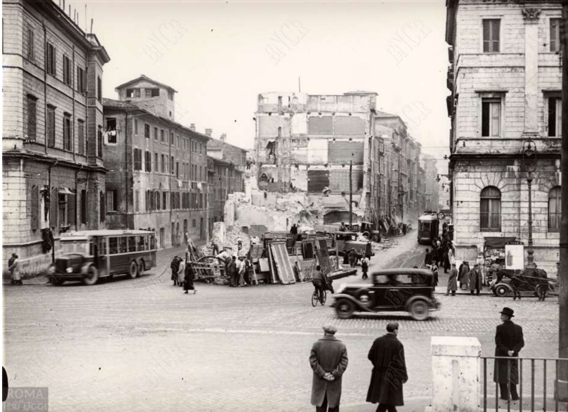
La demolizione della Spina di Borgo per creare Via della Conciliazione (1936)
