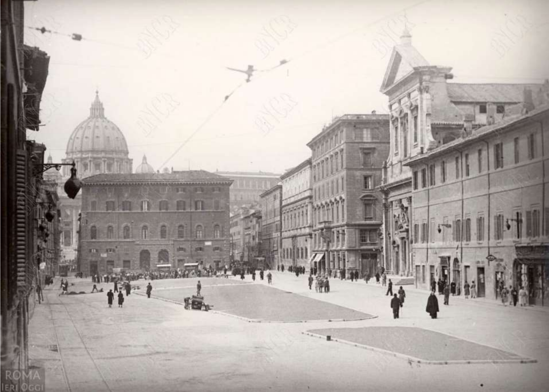
La demolizione della Spina di Borgo per creare Via della Conciliazione (1936)
