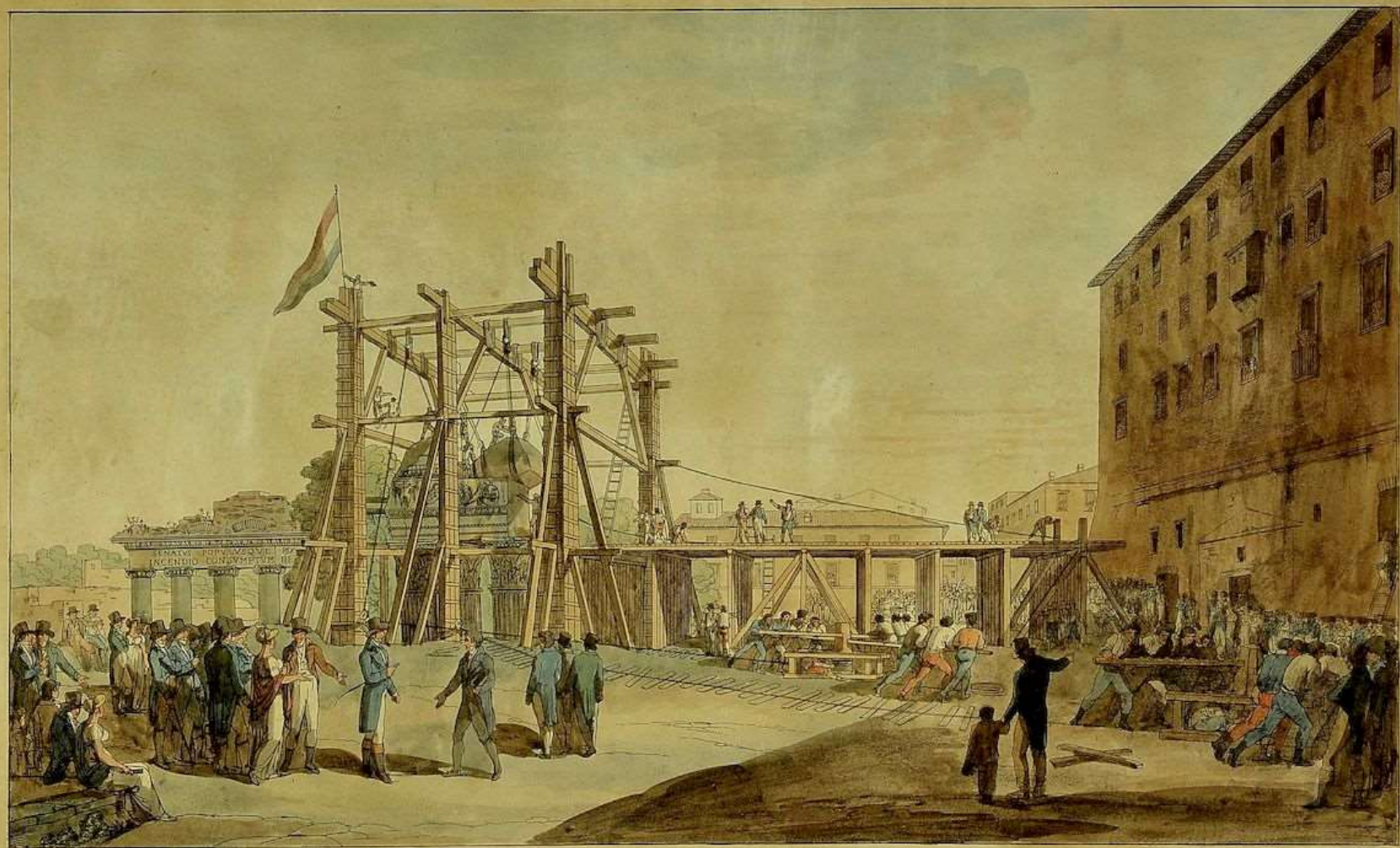
Disegno Prospettico del Castello per lavoro di opera le grandi Massie che formano l'Architrave, Fregio, e Cornice del Tempio di Giove Tonante e riappicare le tre Colonne fuori di equilibrio, eseguite nel preciso momento dell'operazione del primo blocco. Giuseppe Camparini scultore e tore il disegno, che ha immaginato l'opera la esecuzione nel 1812. Biblioteca del Principe di S. Saba. Roma. Giugno. 1812.
