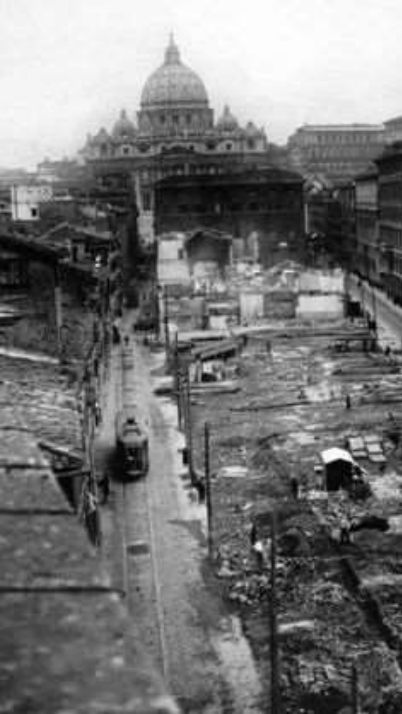
La demolizione della Spina di Borgo per creare Via della Conciliazione (1936)
