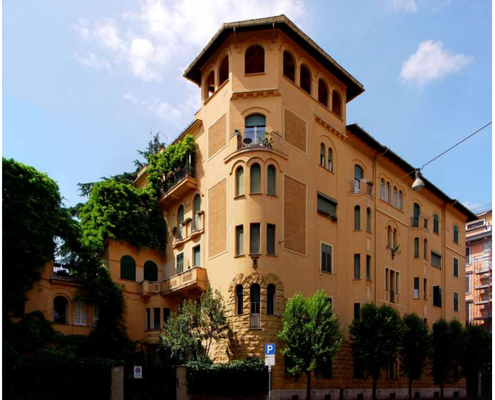
Alberto Calza Bini: Casa Coop Leonardo in via Avezzana 51 (Garbatella)
