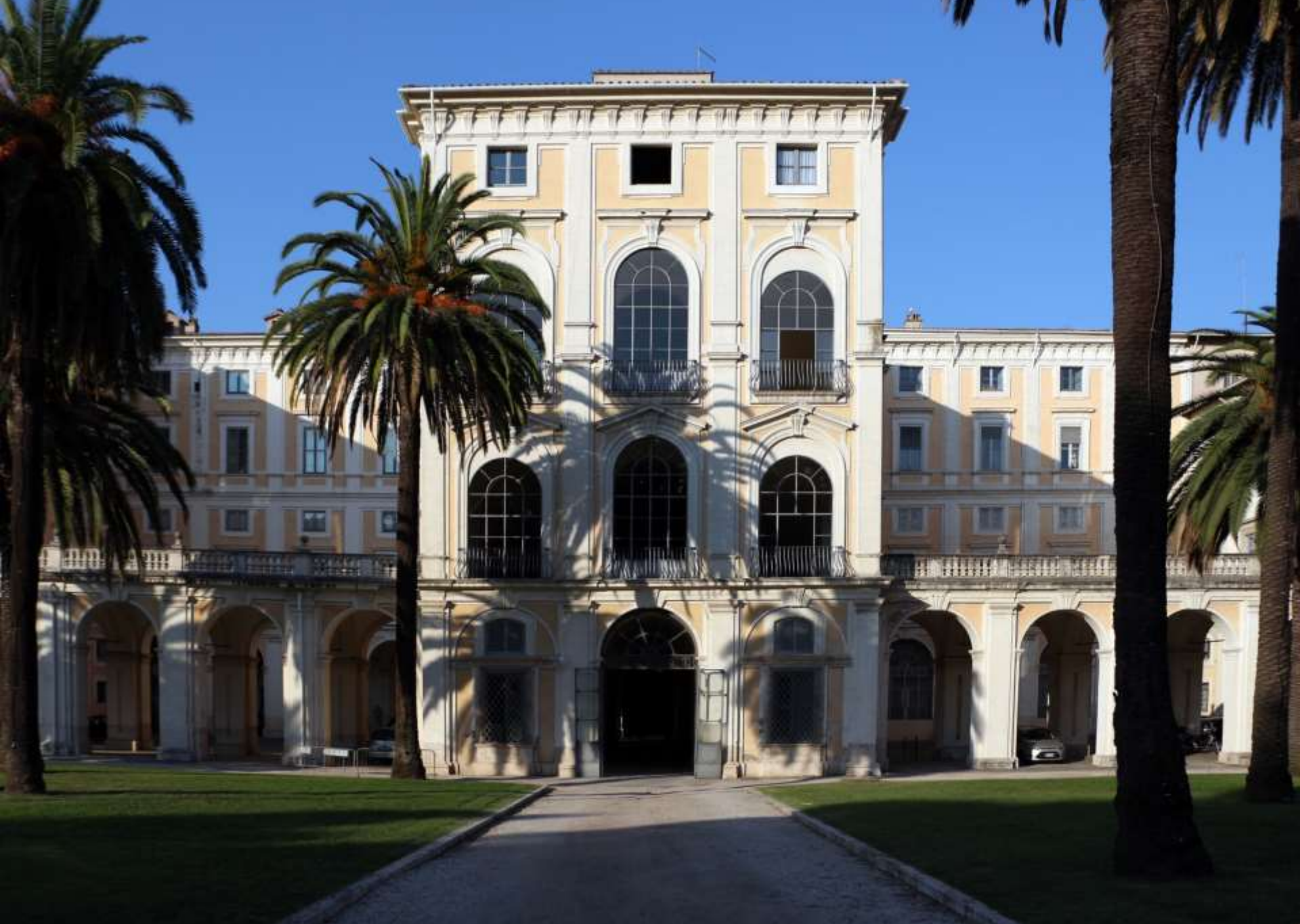
Palazzo Corsini: il fronte interno
