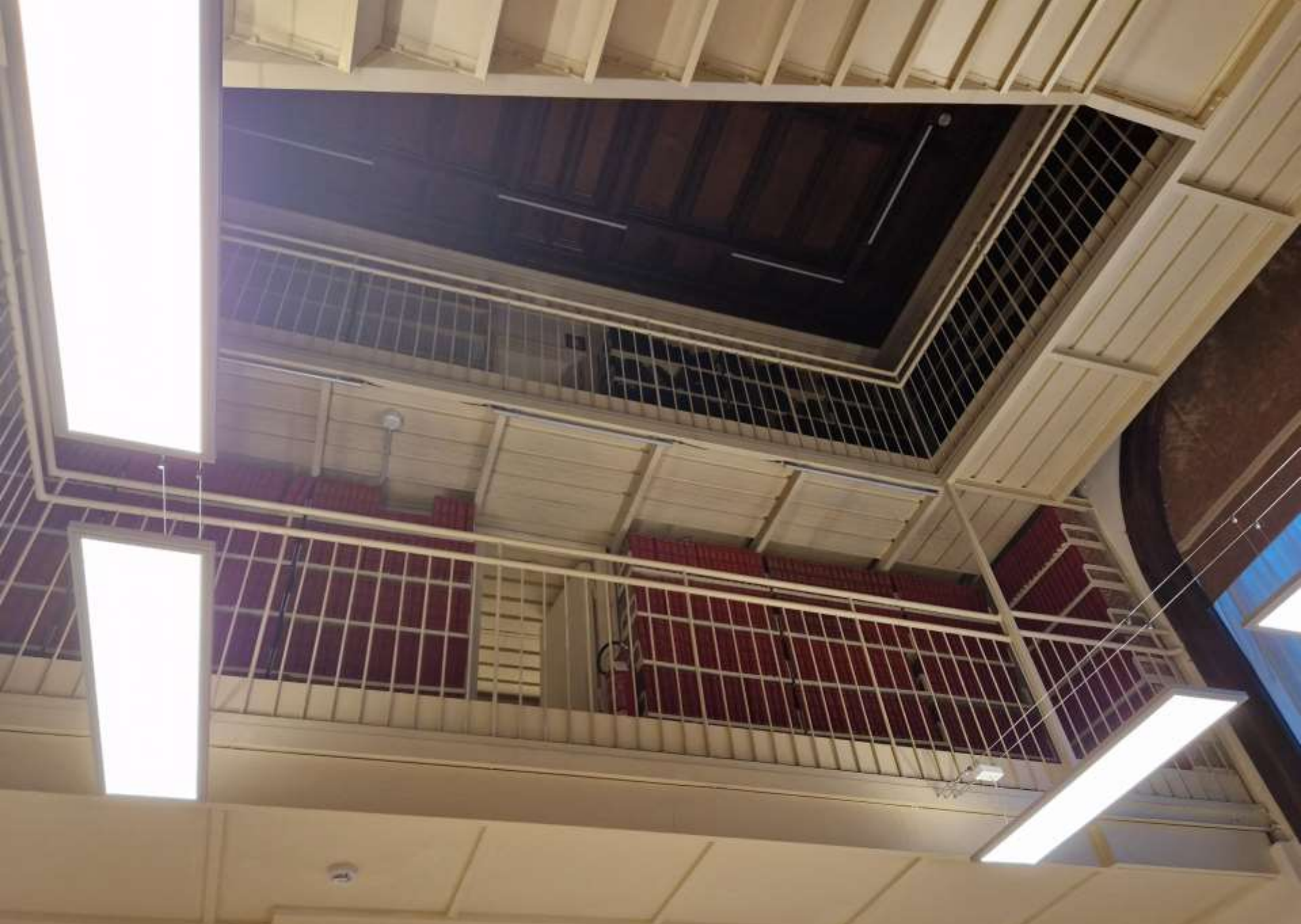
Palazzo di Montecitorio: la sede degli archivi progettata da Ernesto Basile
