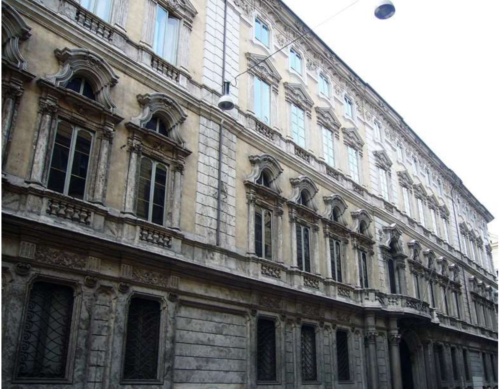
Palazzo Doria-Pamphilj: la facciata su via del Corso
