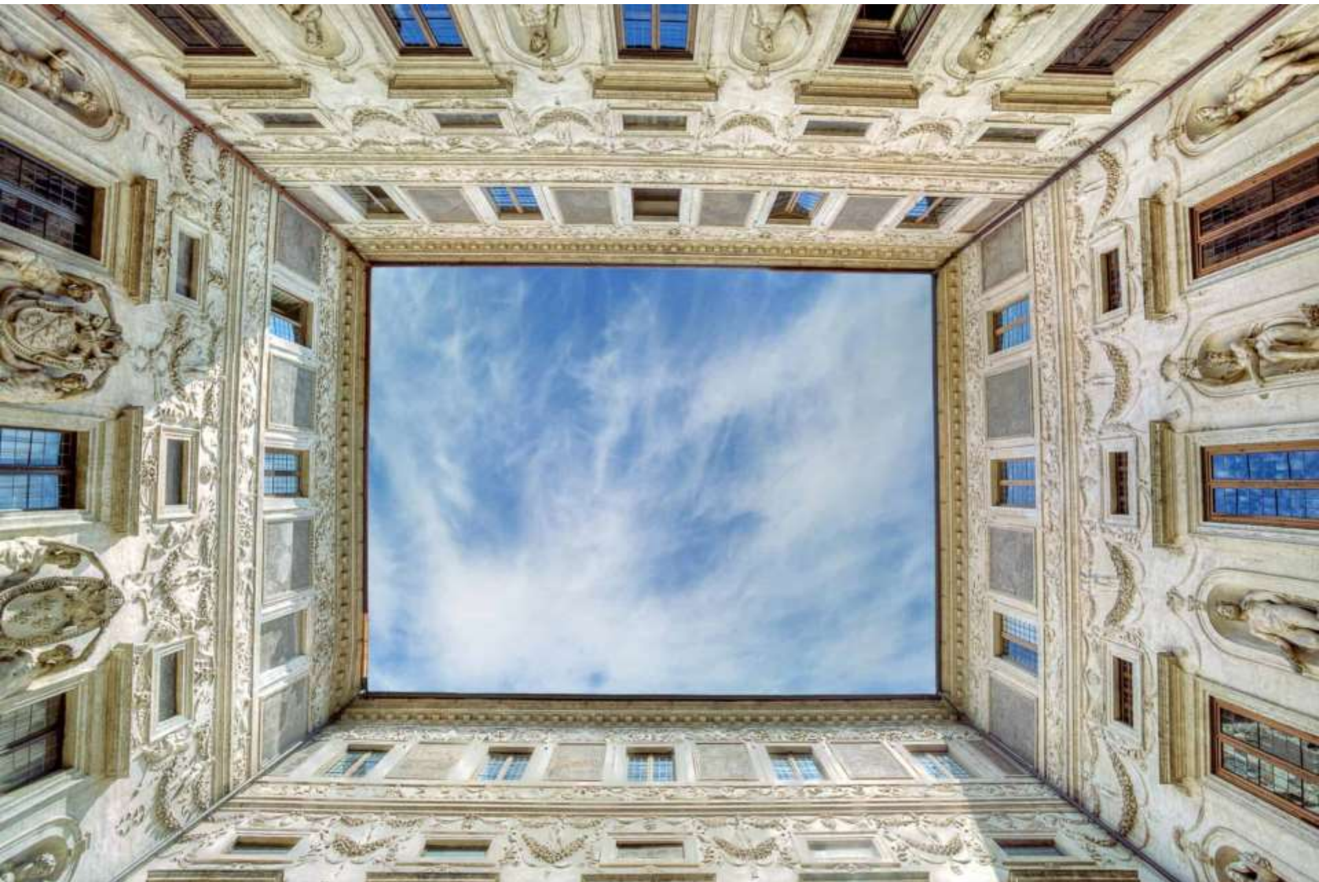
Palazzo Spada: il cortile
