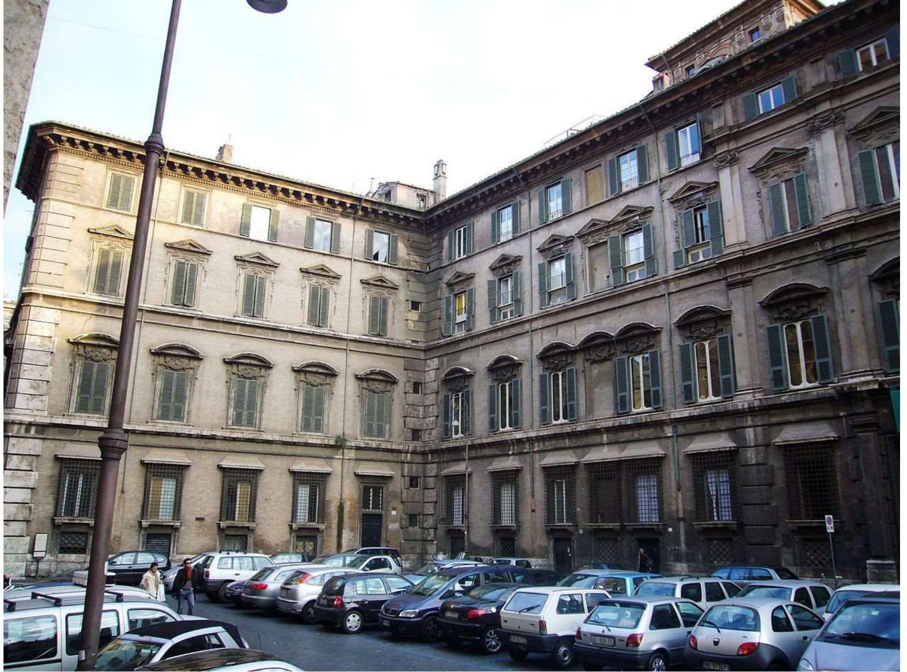
Palazzo Doria-Pamphilj: le facciata sul Collegio Romano
