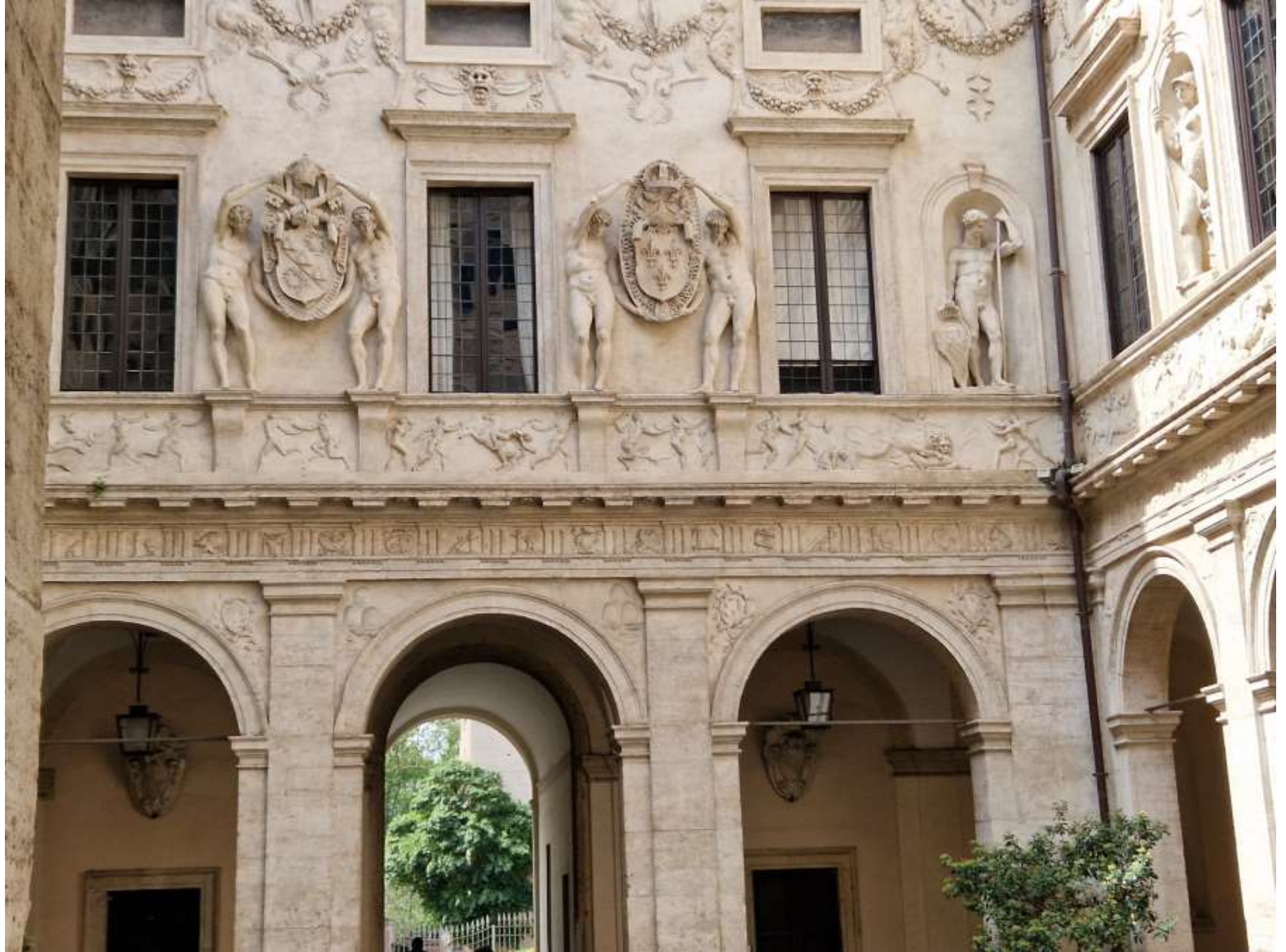
Palazzo Spada: il cortile
