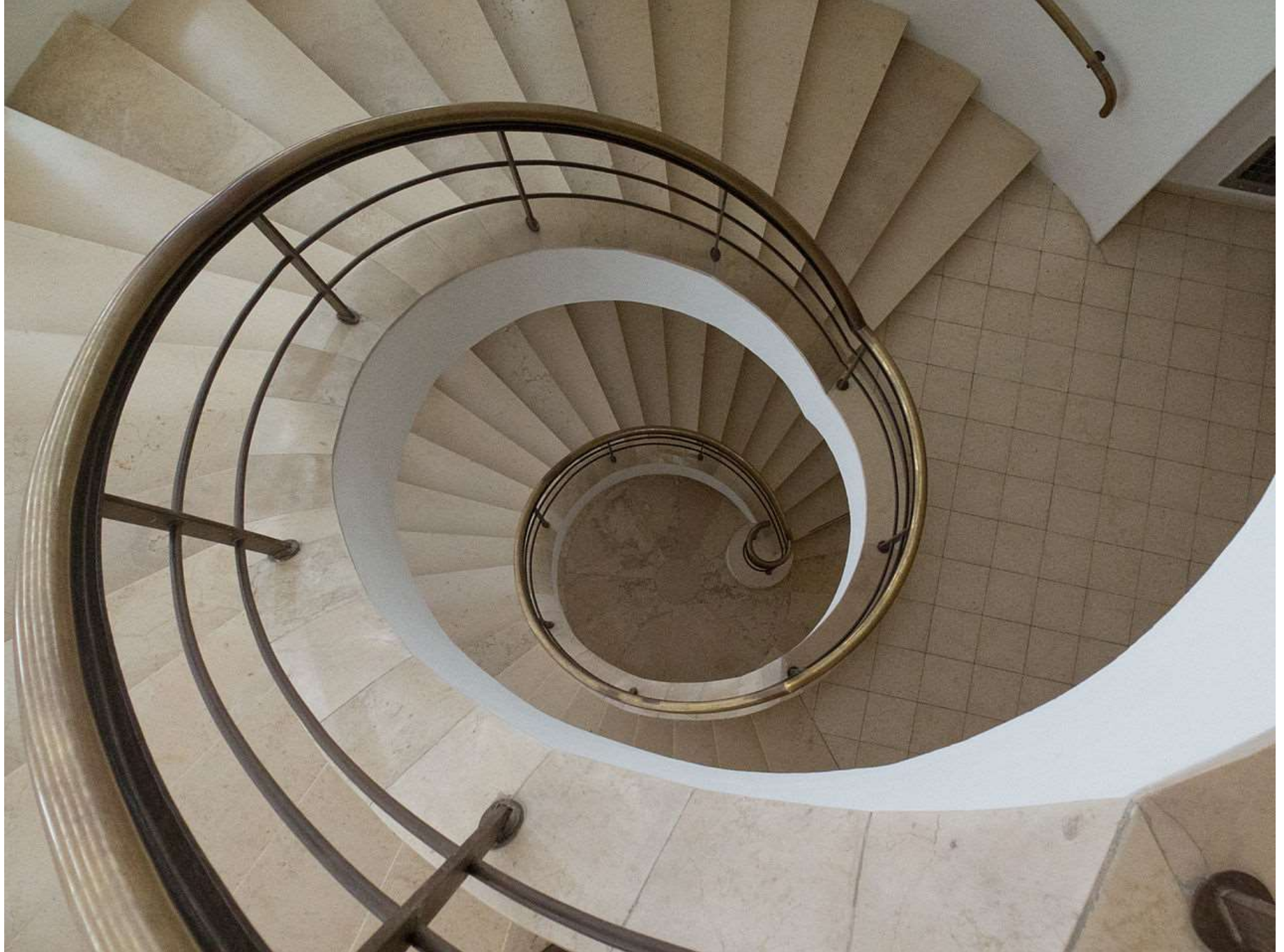
Weizmann House di Erich Mendelsohn: scala a chiocciola della torre (1937, Rehovot, Israele)
