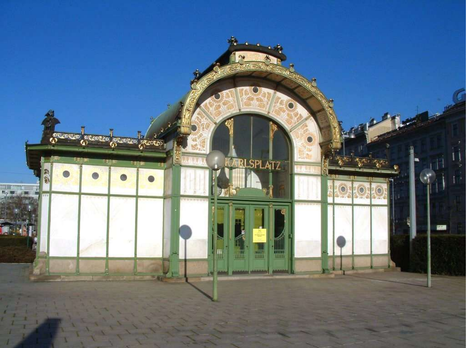
La stazione metro di Karlsplatz di Otto Wagner a Vienna (1900, Austria)
