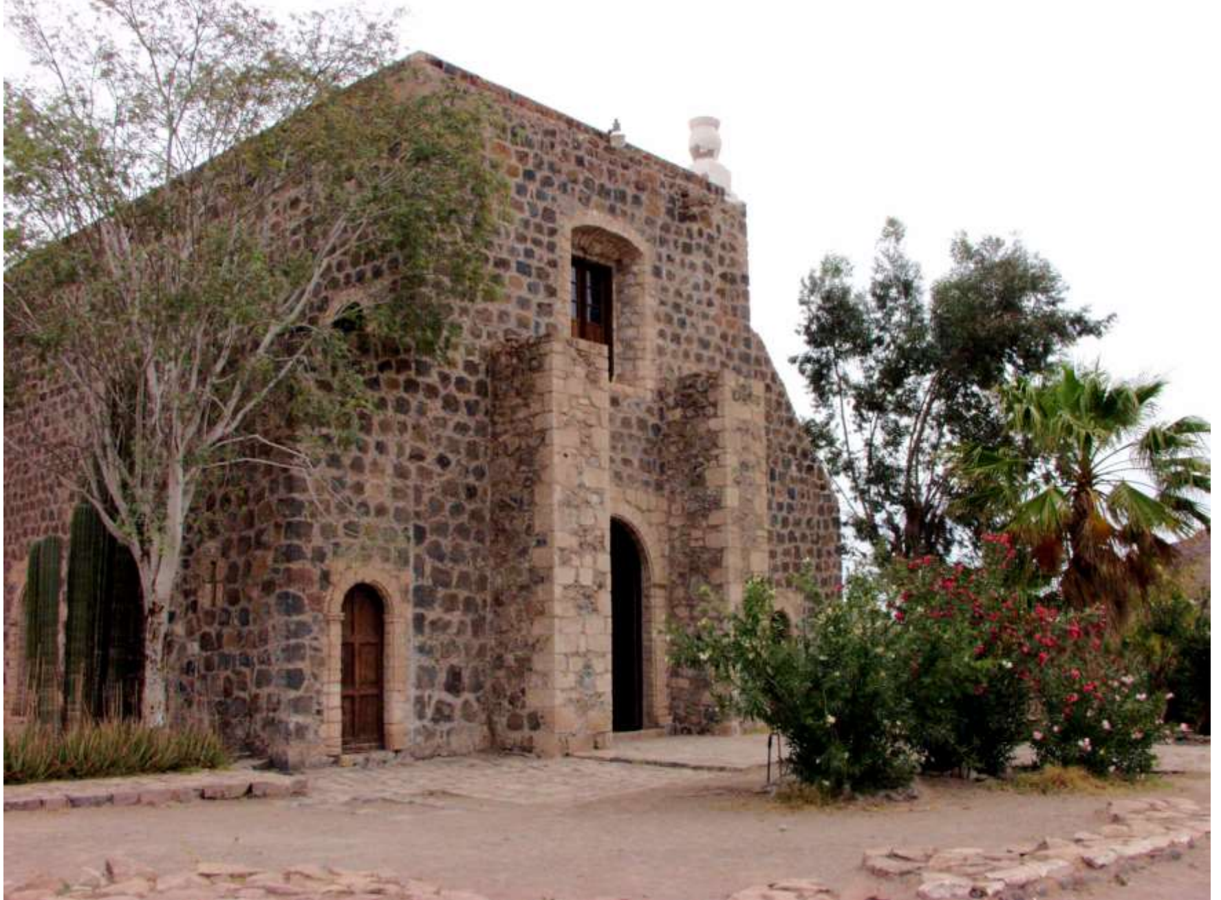
Santa Rosalía de Mulegé (Baja California Sur, Mexico)
