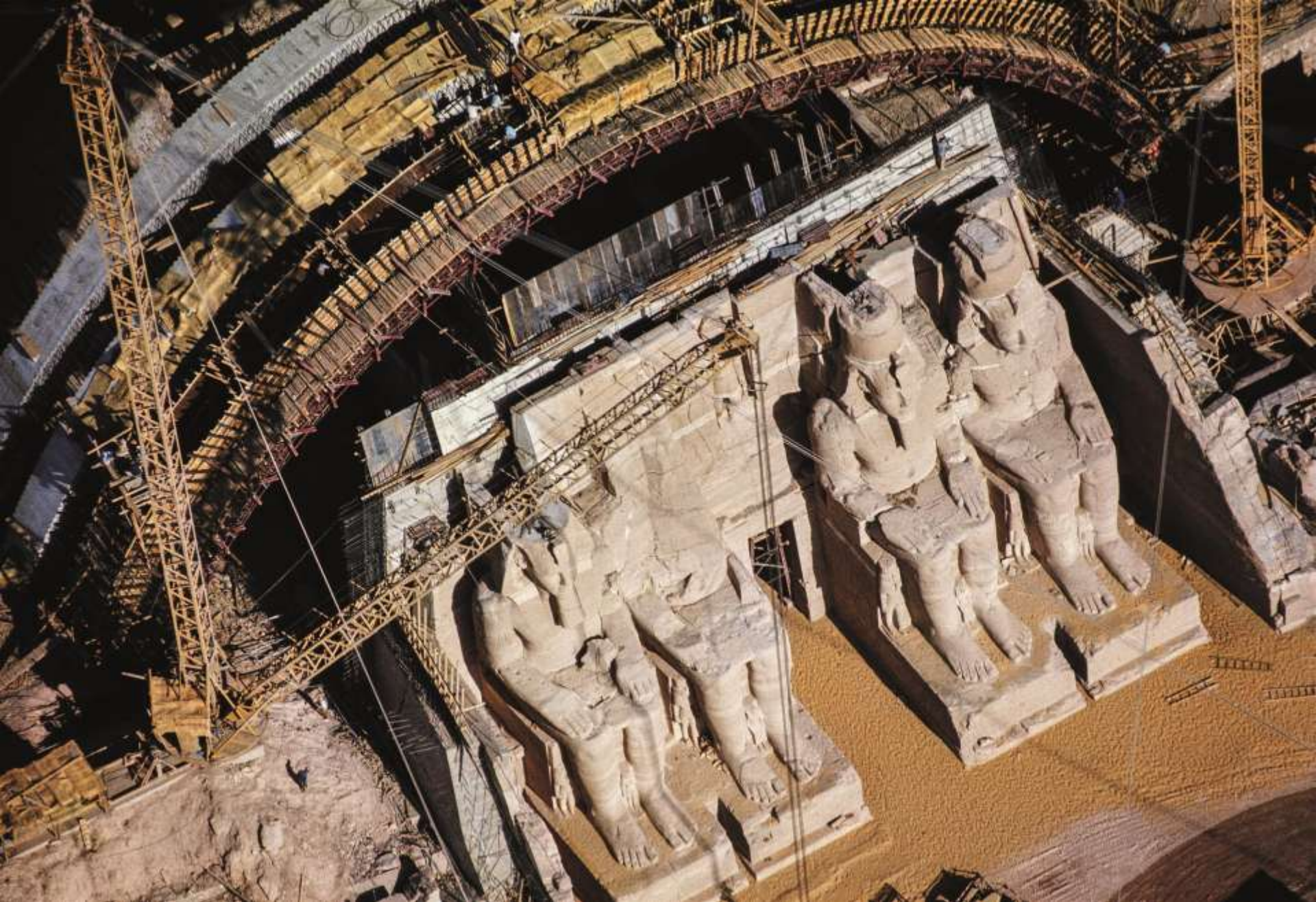
Abu Simbel: Le volte di calcestruzzo per coprire il tempio di Ramses (1966)
