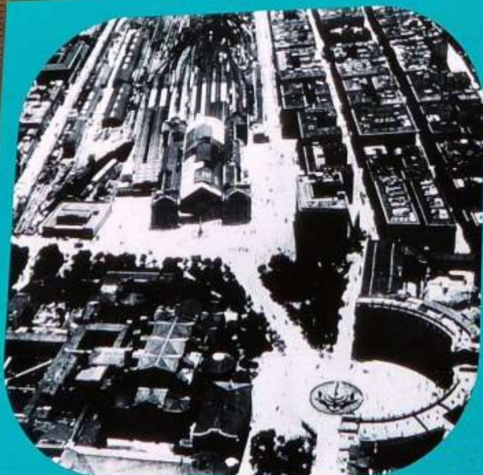
La prima stazione su progetto di Salvatore Bianchi realizzata tra il 1869 e il 1874
