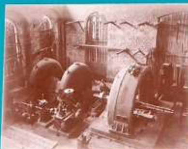
Centrale idroelettrica di Castel Madama in fase di costruzione, 1915
