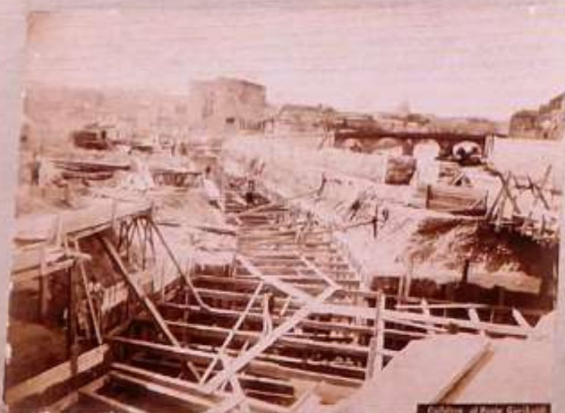
Collettore al Ponte Garibaldi
